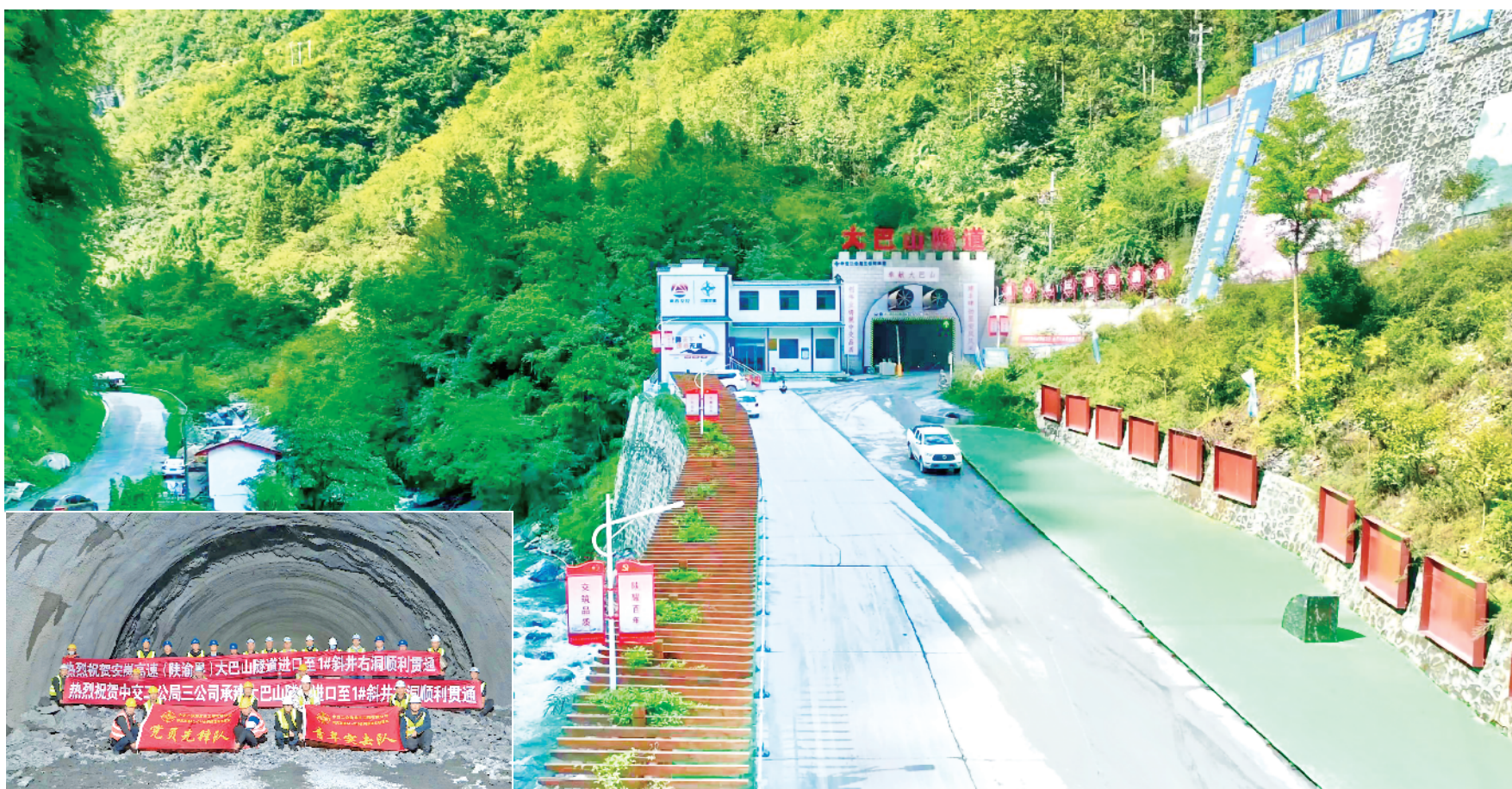
9月28日，由中交二公局第三工程有限公司承建的国家高速公路网银百线(G69)陕西段安康至岚皋高速公路项目——大巴山隧道实现隧道进口至施工斜井段右洞顺利贯通。据了解，大巴山隧道是安康高速的控制性工程，具有“地质复杂、纵坡长、埋深大、单向掘进长”的显著工程特点，也是陕西省在建项目中的最长隧道。
