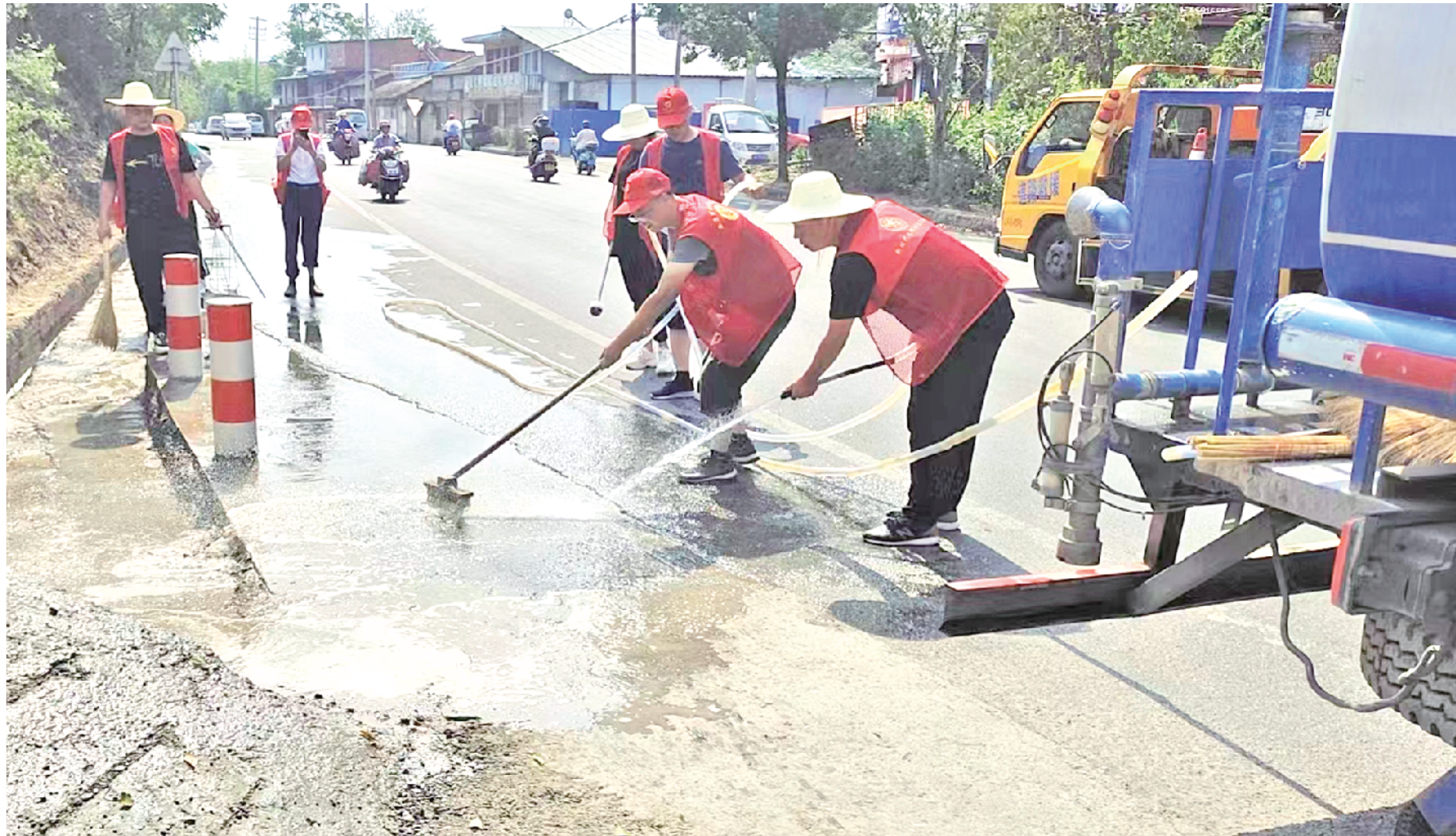
9月5日和6日,汉滨区关庙镇吴家村村创文帮扶单位统计局协调市公路局,连续两天对316国道吴台段排水沟进行冲洗、清淤。
