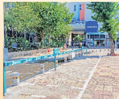
泊车公司建设的电动车充电桩
