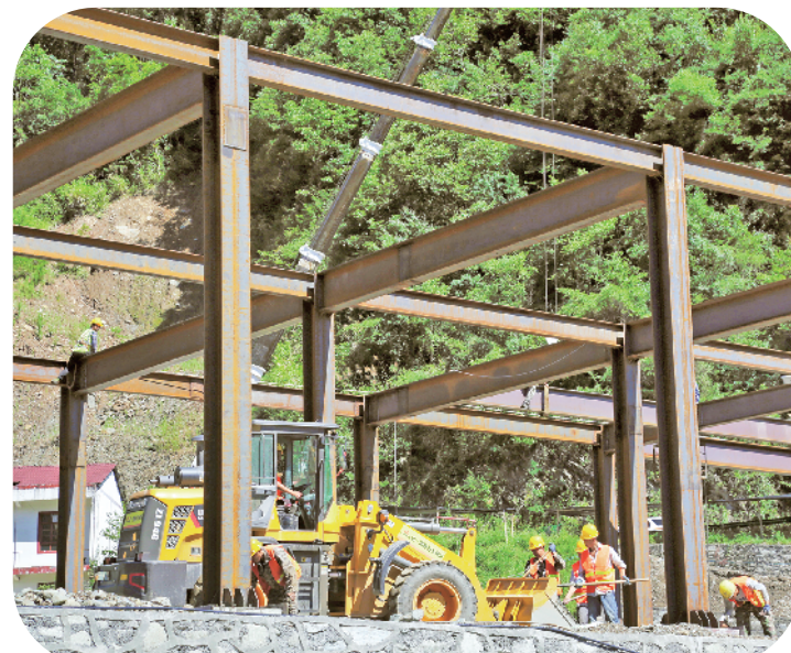
镇坪县曾家镇中药保健食品加工园项目，是镇坪县围绕打造中药首位产业策划实施的重点项目。该项目借助高校科研优势，引入江苏食品药品职业技术学院，围绕镇坪资源禀赋打造专项技术开发项目，总投资1.6亿元，新建年产200吨保健酒生产线、100万件包装生产线一条，计划12月底前实现试生产。 记者 吴单 摄
