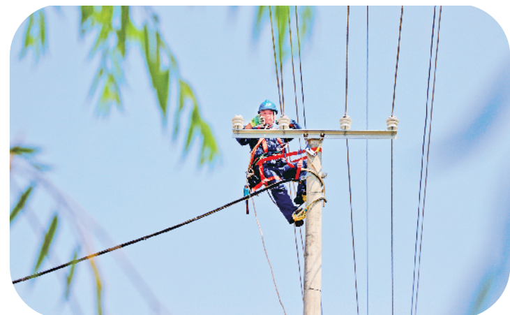
为加快推进全市重点企业建成投产,连日来,国网石泉县供电公司战高温、冒酷暑,仅用10天时间完成经开区自嗨锅西北基地供电设备安装和线路架设,用实际行动加大对地方经济发展建设的支持力度,以电力赋能乡村振兴,服务稳增长大局,助力地方经济高质量发展。图为近日国网石泉县供电公司在经开区进行线路架设作业。 汪厚庭 摄
