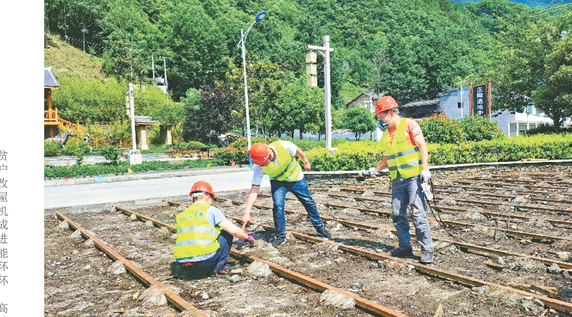
近年来,平利县正阳镇积极盘活村级集体经济,探索乡镇劳务服务公司发展路径,在张家坝村先行试点,村集体参与入股成立“大巴人”劳务服务公司,通过劳务输出、劳务承揽等方式,积极对接经营主体,产业大户,帮助闲置劳动力尤其是就业困难人员实现就业和灵活就业,切实增加村集体经济及务工群众收入。图为“大巴人”劳务服务公司承接乡村振兴示范村公共设施提升改造项目。
