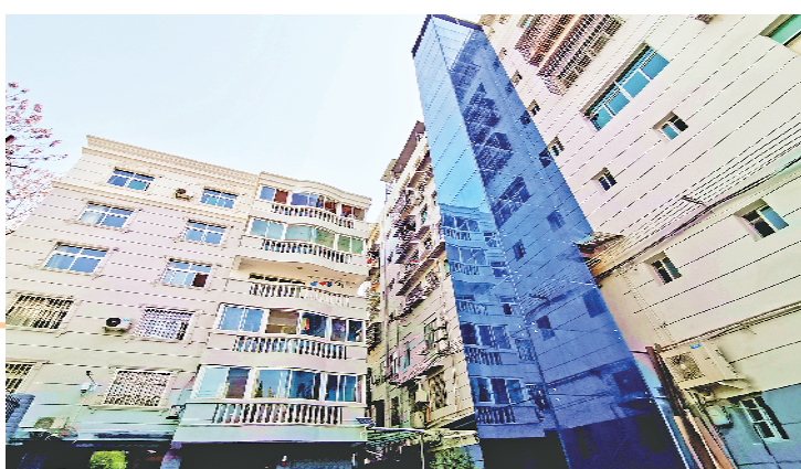
老旧小区改造后加装电梯
