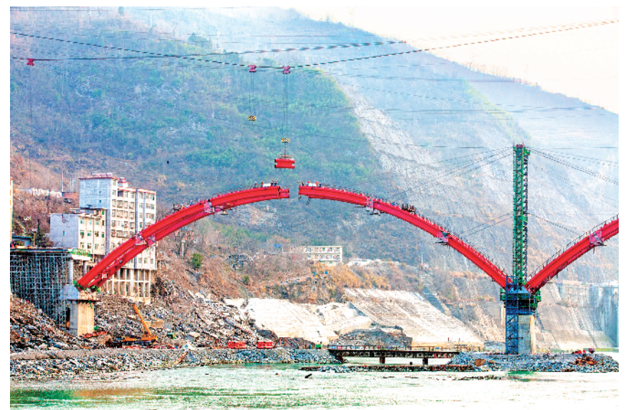
2月15日,元宵节日的旬阳蜀河汉江大桥建设工地一派繁忙景象,大桥建设者正抓紧施工确保如期通车。 郭圣杰 摄
