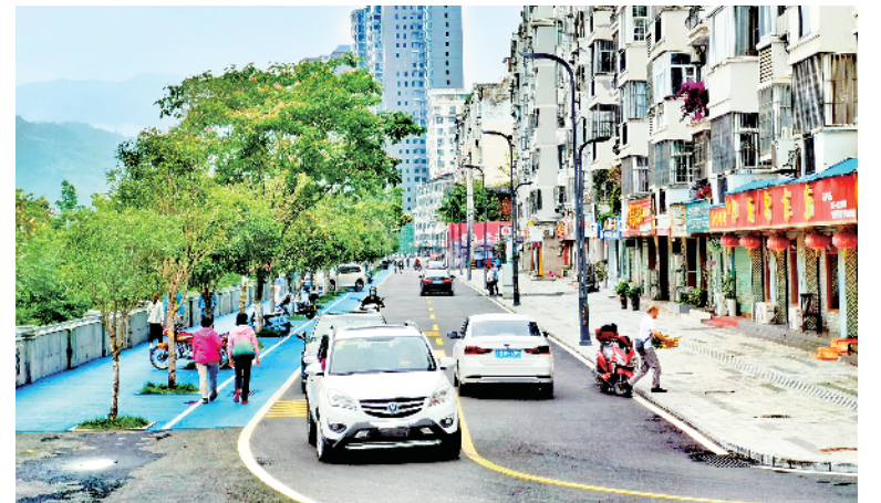
滨江大道改造提升工程是石泉县2022年度实施的重点民生实事项目,东起春湖南西侧与向阳路相接处,西至杨柳大桥头,通过积极争取资金和加快施工,目前大道已经全线贯通。 许兵 摄
