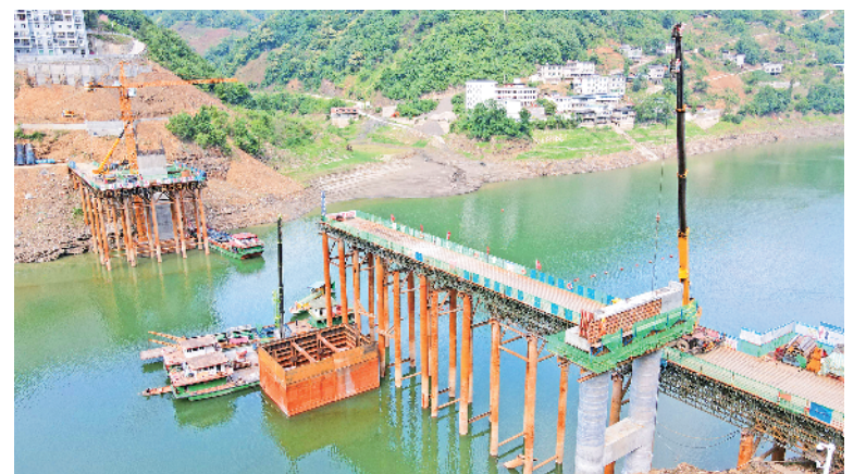
5月26日,国道541紫阳段控制性工程——和平汉江大桥正在加紧施工。该桥通车后,能拉近两岸间的“距离”,便利沿线居民出行,联通石紫岚(石泉、紫阳、岚皋),对县域经济发展具有重要意义。 储茂银 摄
