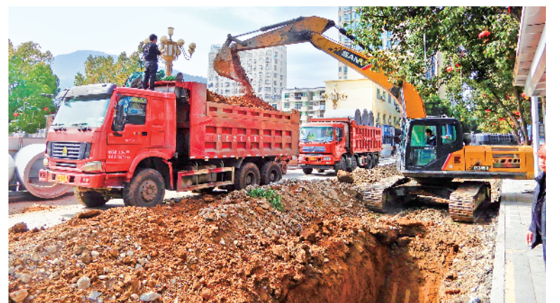
2月20日,平利县新正街项目施工现场,大型机械正在作业。今年以来,该县以提升城市品位、加快“五美平利”发展为突破口,同时按下重点项目开工“启动键”和高质量发展“推进键”,掀起了项目建设的热潮。 刘应珊 摄
