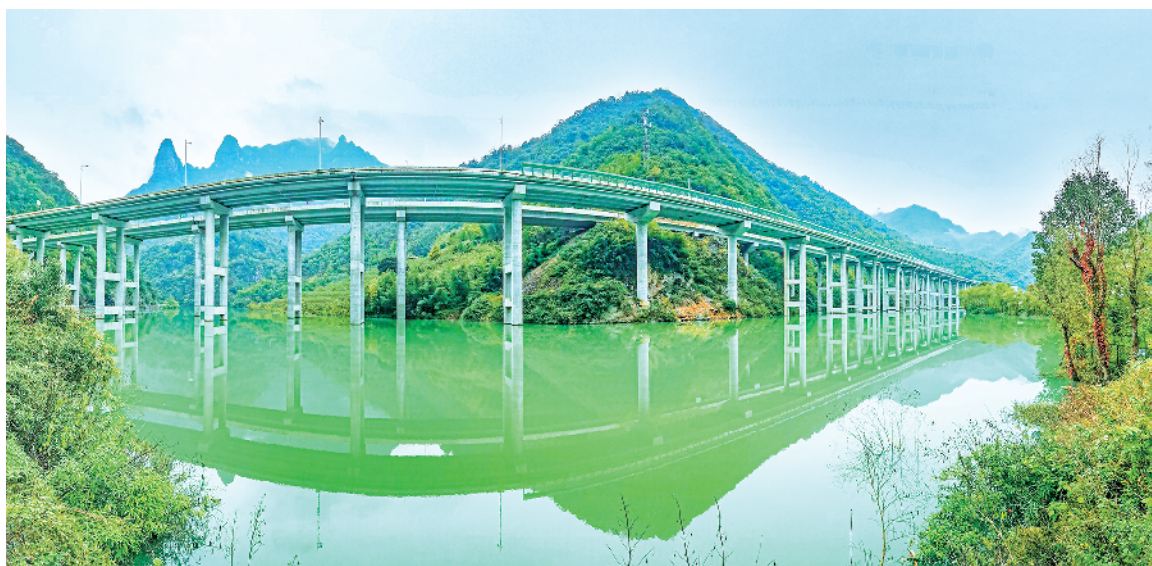
安康至岚皋高速路段全长47.414公里,起于汉滨区建民镇忠诚村,设枢纽立交与十天高速相接,止于岚皋县城关镇塘湾村,设岚皋互通立交与省道207相接。本段概算投资83.33亿元,设桥梁39座、隧道9座,桥隧比84.5%,设互通立交4处、服务区1处、收费站3处。图为安康高速岚皋县蜡烛山大桥。 陈德模 摄
