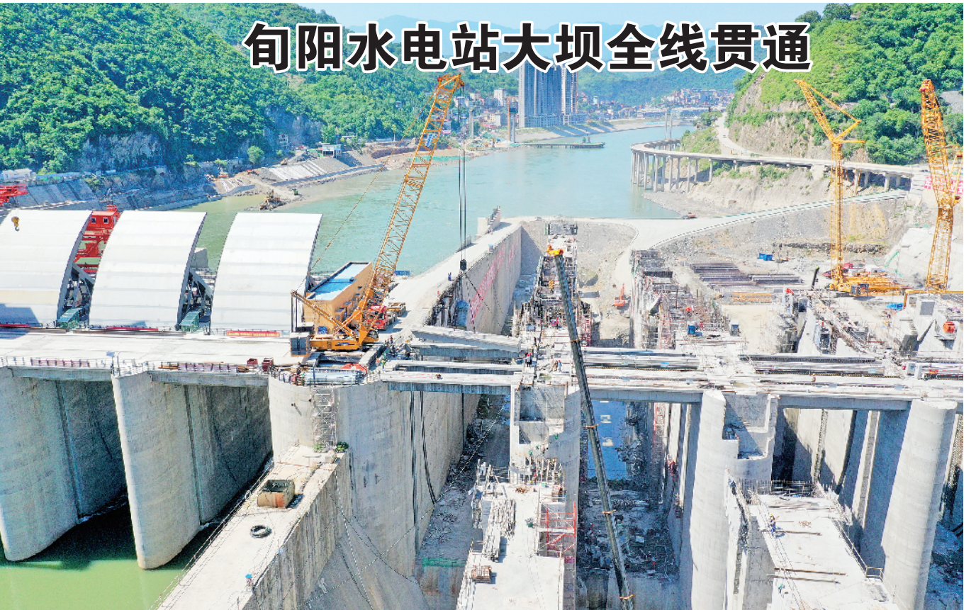
6月14日20时51分,随着旬阳水电站大坝坝顶最后一榀交通梁吊装到位,右岸坝顶交通梁全部架设完成,标志着旬阳水电站全长462米的大坝实现全线贯通。旬阳水电站是陕西省重点项目,是陕西省、安康市重大民生工程,总投资40.79亿元,设计安装4台80MW发电机组,总装机容量320MW,年发电量8.4亿千瓦时,预计2022年底建成投产发电。记者 唐波 通讯员 王建华 摄
