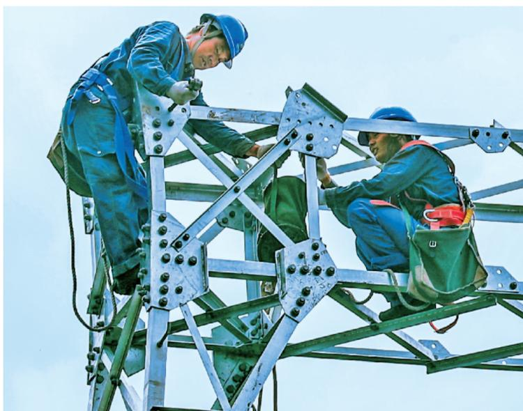
6月14日正午时分,在安康市汉滨区月河川道南坡的凤凰山上,安康供电局架线班的工人们顶烈日斗酷暑,在几十米高的铁塔上挥汗如雨、忙碌作业,架设从恒口变电站到大东山转输台约15公里的10千伏高压线路。据了解,新线路(高空)架设任务预计6月底前完成,将从根本上解决旧线路杆多、线长、低矮、老化及“线与树”矛盾等问题,从而提高抗拒风雨雪等自然灾害影响的能力。张思成 摄
