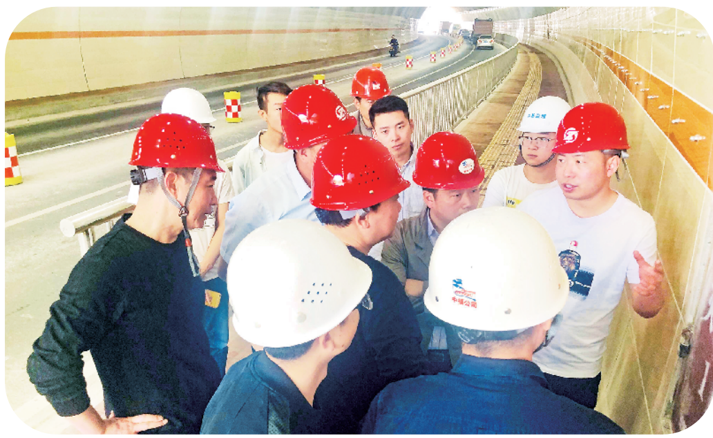
郑才林在施工现场。
