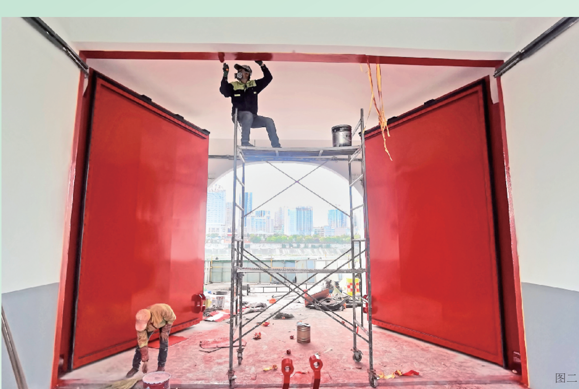
1983年特大洪灾后, 在中、省领导的关心支持下, 安康城区迅速重建。水毁了的防洪闸门和大堤也于1987年建成并于当年的11月24日进行验收。图一是当年夏季建成后的水西门闸门, 图二是去年年底有关部门对水西门、金川门、朝阳门等防洪闸门进行维护。目前, 水西门防洪闸门已维护竣工。
