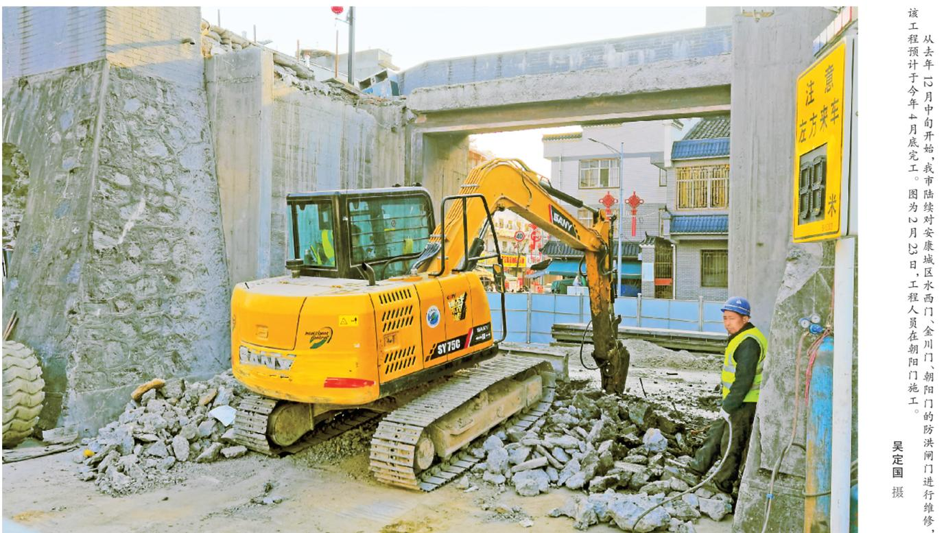
从去年10月中旬开始,我市陆续对安康城区水西门、金川门、朝阳门的防洪闸门进行维修,该工程预计于今年十月底完工。图为10月15日,工程人员在朝阳门施工。
