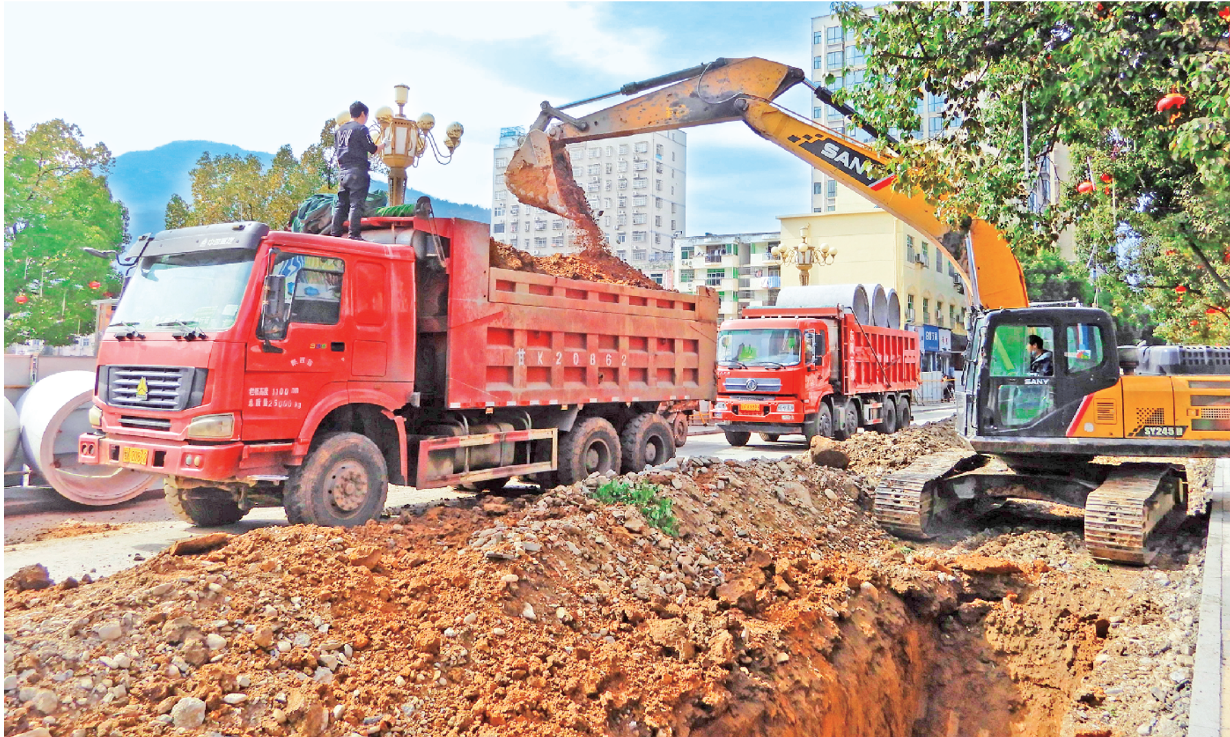
2月20日,平利县新正街项目施工现场,大型机械正在作业。春节以来,该县以加快“五美平利”发展为突破口,同时按下重点项目开工“启动键”和高质量发展“推进键”。目前全县首季开工项目17个,总投资达21亿元。
