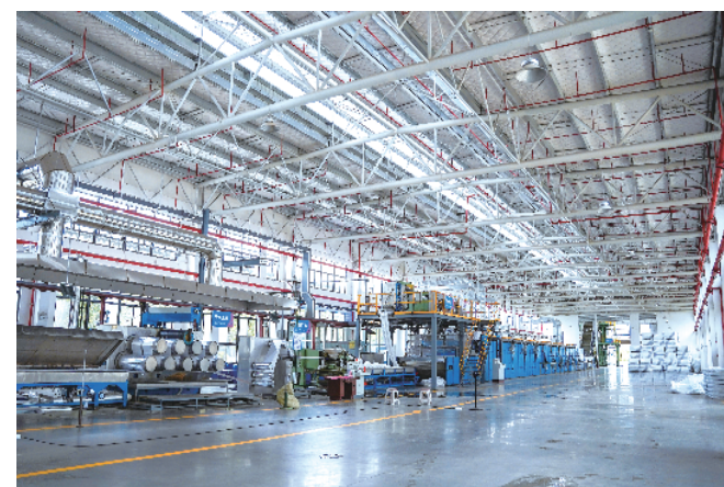
恒通纤维样板生产车间
