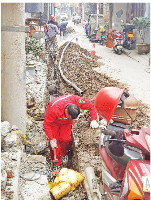
在安康城区的小北街纱帽巷,天然气公司的工人正在加管施工现场。如今,天然气管道铺设到了安康城区背街小巷。
