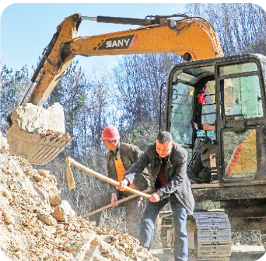
崔义胜参与道路修复施工。
