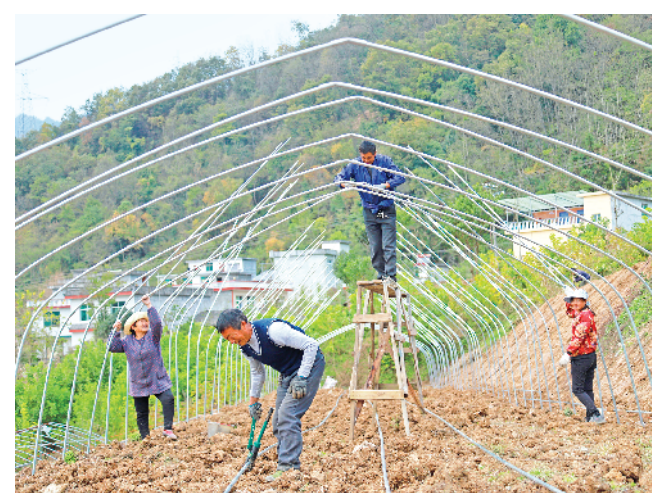
连日来,在岚皋县城关镇茅坪村众达农业园区蔬菜保供基地,10余名工人忙着固定支架、搭建大棚,抢工期、抓进度。该项目总投资340万元,将建成蔬菜保供基地13.3公顷,后期将同时做好“农业+旅游”融合发展,为农业产业“补链”“强链”,助力乡村振兴。
