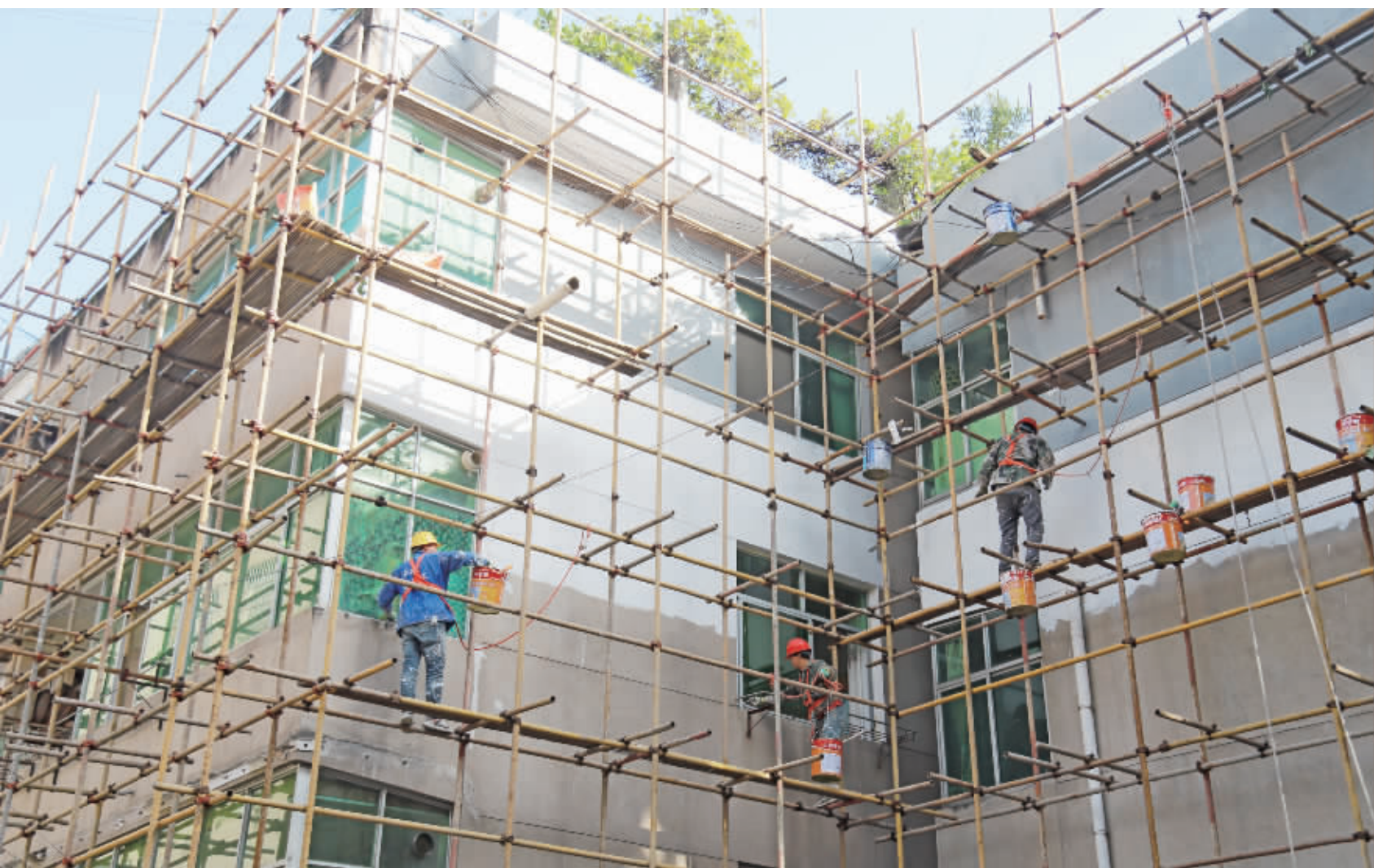
连日来，岚皋县城凉泉小区内热闹非凡，建筑工人正忙着为这个老旧小区穿“新衣”，正在“变身”的凉泉小区，是岚皋县老旧小区改造工作的进行而大背景。
