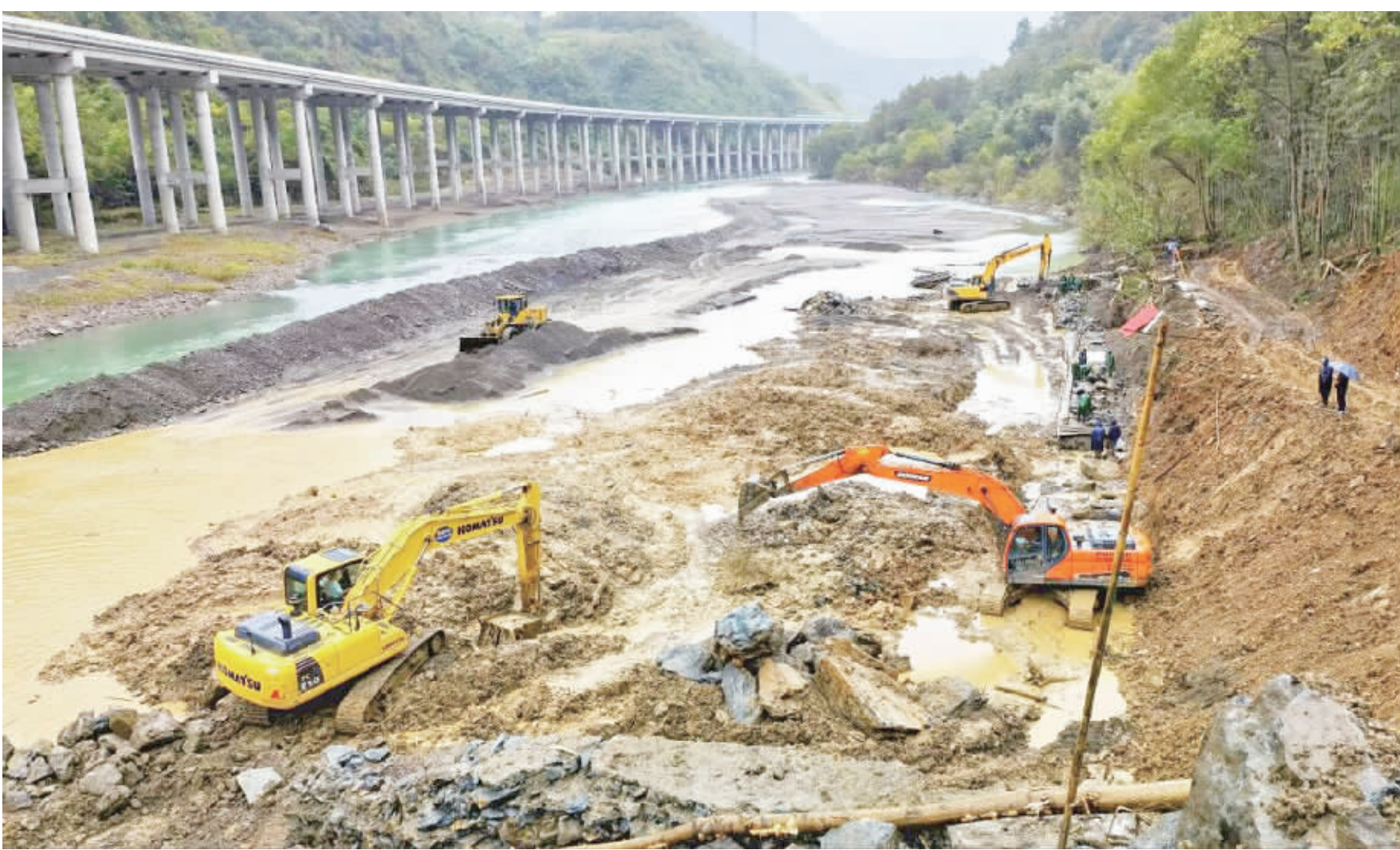
20月以来,岚皋县连续遭遇多轮强降雨天气,境内多处水利设施受损严重。灾情发生后,岚皋县水利局组织施工单位冒雨开展岚河城关镇水田村段堤防工程重建工作。图为10月10日,岚皋县水利局组织施工单位冒雨开展岚河城关镇水田村段堤防工程重建工作。
