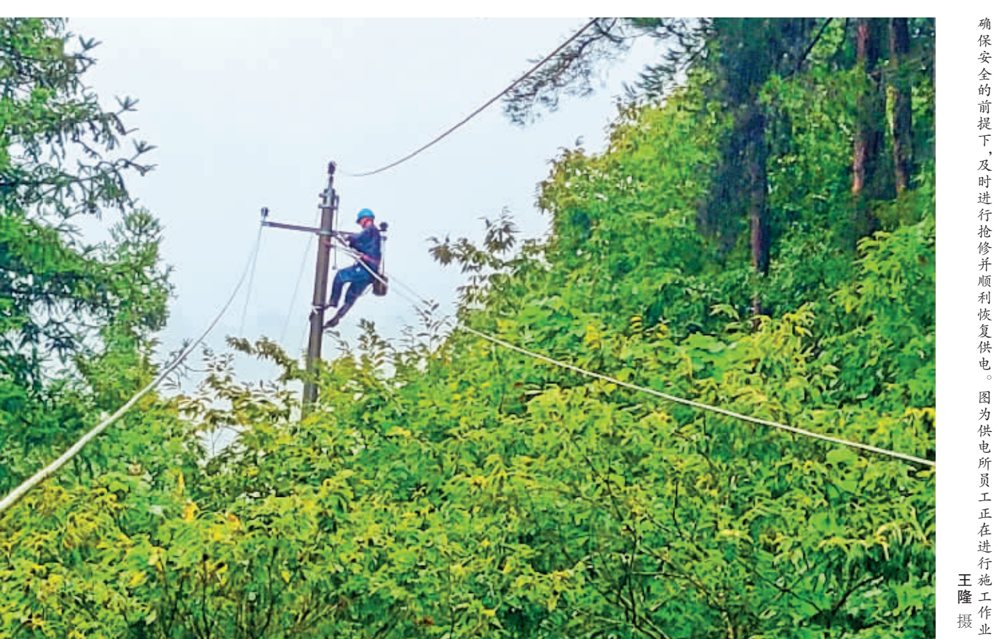
近日,平利县洛河镇三坪村部分供电线路受损,该镇迅速行动,组织相关部门人员在确保安全的前提下,及时进行抢修并顺利恢复供电。图为供电所员工正在进行施工作业。王隆 摄
