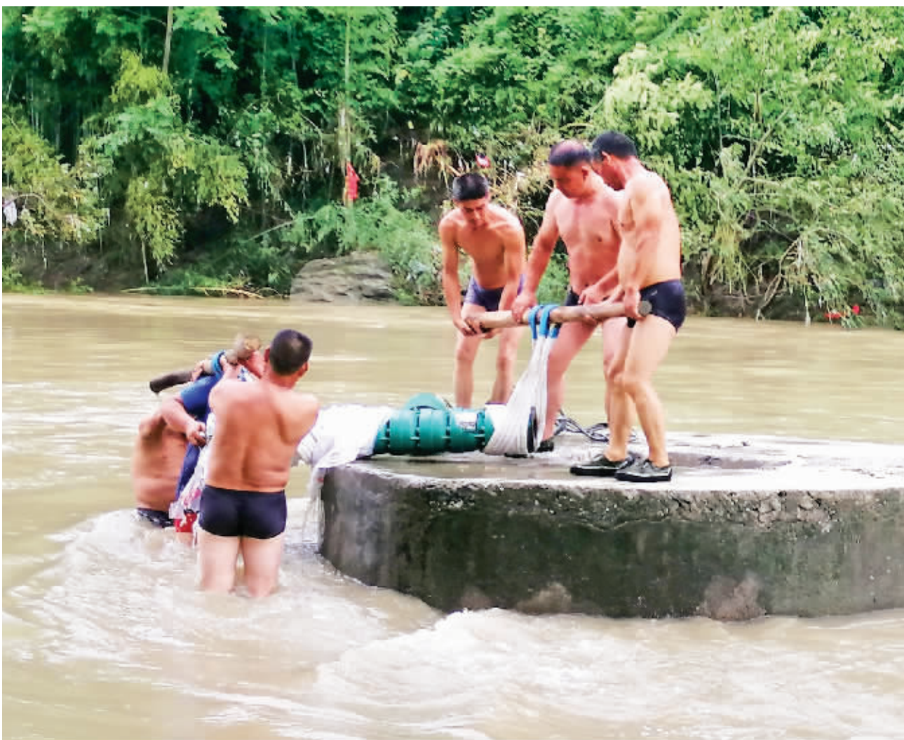
8月30日，汉滨区张滩镇汪岭水厂取水井因杂物倒灌入内，水泵出现故障。图为工作人员正在抢修取水井，更换水泵。王丽萍 邓良东 摄
