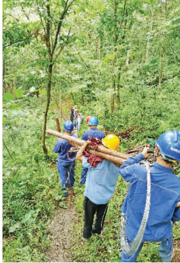
为改善岚皋县石门至红光交通基础设施条件,促进地方发展,提升乡村规划能力,顺利实施乡村振兴目标,近期,该县供电公司石门供电所积极配合交通部门,全力做好石门至红光公路拓宽工程的电杆线路迁移工作。此次工程需对公路沿线的0.4千伏线路进行迁移,涉及21处电杆及一处配变。时间紧、任务重,按照政府交通部门要求,公司立即组织技术人员对工程进行实地勘察,并制定了科学合理的实施方案,石门供电所组织精兵强将迅速投入到施工场地,按照公路项目部施工进度要求,全力以赴加班加点完成施工。截至目前,已完成一标段和三标段所有电杆迁移工程,后续工作正在紧张有序的进行当中。何军摄
