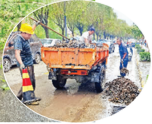
近日,宁陕县住建局结合防汛工作实际,组织对城区排水管道进行全面清理,确保城区雨水排放畅通。目前,已完成全县主次干道(一)余个雨水管道及沉积清理工作,共更换加固雨水篦子、井盖七个,清运管道垃圾30吨。
