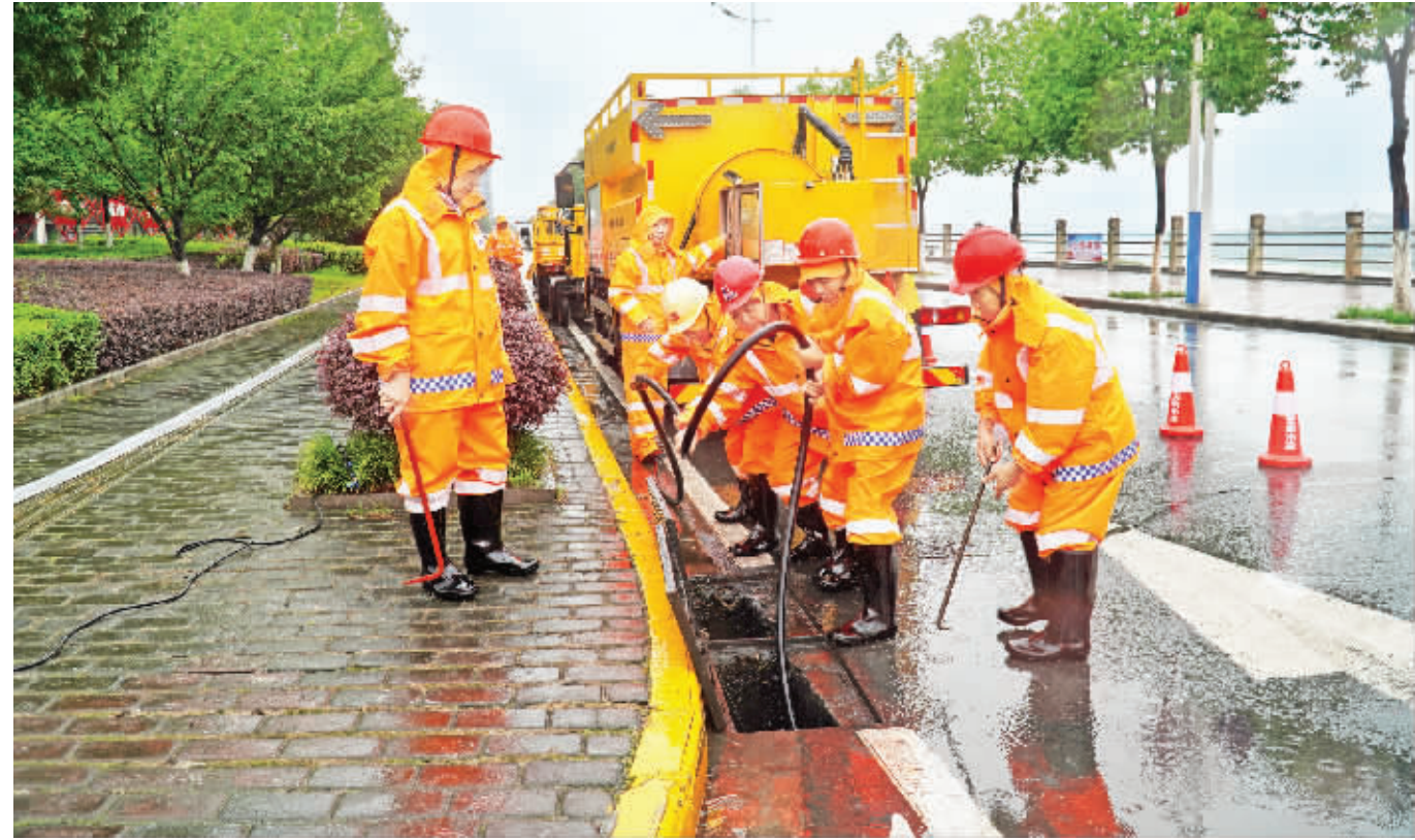
为防范中心城区因大雨导致内涝及其他险情发生,6月25日,安康市市政园林处结合城市排水防涝预案,组织值班组、道路积水组、绿化抢险组、泵站抽排组等8个小组共83人,在安康市喇叭沱防汛泵站、枣园路、汉江一桥北转盘等地进行实战演习。
