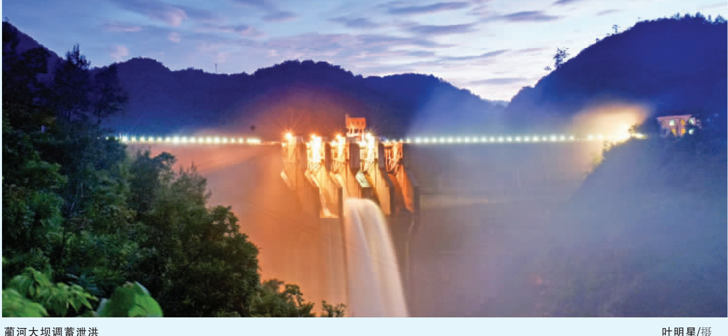
蒹河大坝调蓄泄洪
