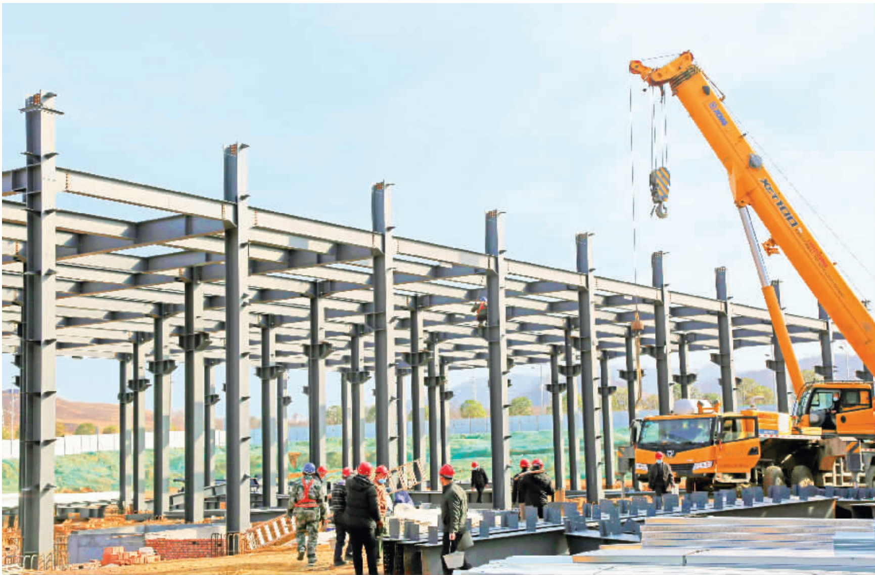
近日,石泉县池河镇小微企业孵化基地项目现场一片繁忙的建设景象。去年以来,石泉县积极克服疫情影响,相继谋划实施了一大批补短板、夯基础、蓄动能、促发展的重大项目,固定资产投资在逆势中实现正增长,有力促进了县域经济恢复性增长,为全县“十四五”开好局、起好步,实现首季“开门红”奠定了坚实基础。 许兵 摄
