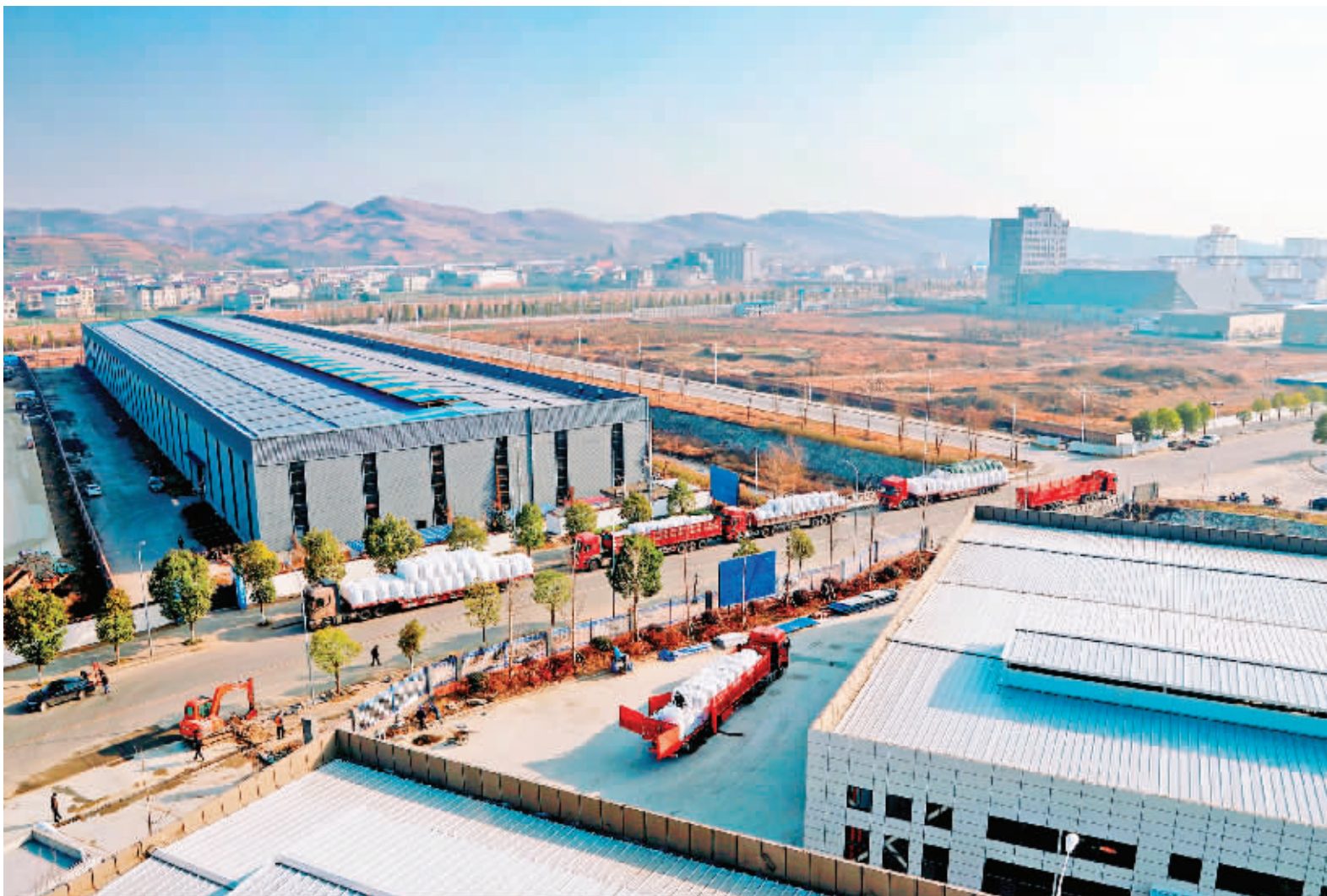
标准化厂房逐渐成为项目建设的主战场,对外开放的主窗口、高质量发展的主引擎。恒口示范区引进产业项目一疏好标准,在工业产业园内建设占地200余亩、总建筑面积约50万平方米,其中包括2000平方米仓储、标准厂房、配套设施等,为全市毛毯玩具文创产业和安康“无水港”项目的顺利实施提供有力保障。 记者 吴单 摄
