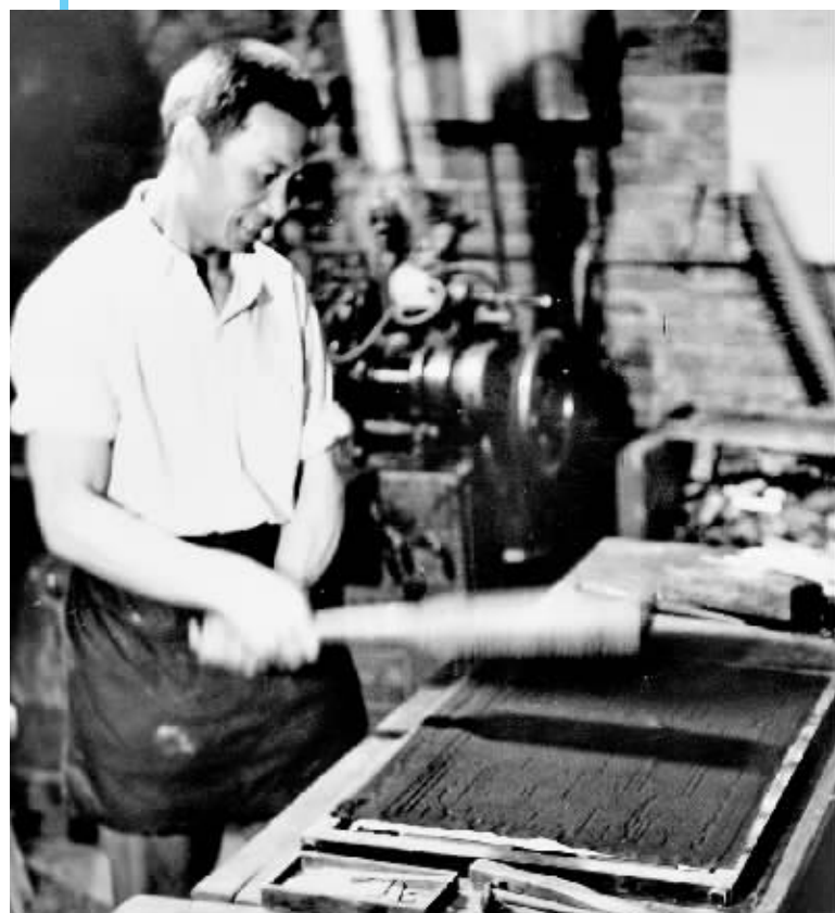
排字房排出来的铅字用多层加工的纸张通过几百次的刷子捶打成模子,用铅水将其浇灌成铅版才是报版,再去印刷厂印出来的就是报纸了!
