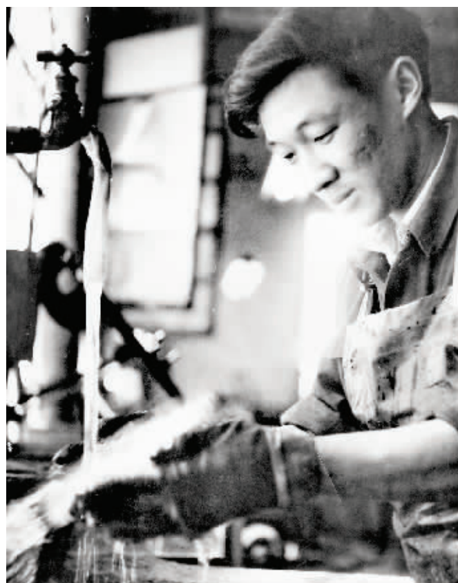
工厂制版工人王明顺(已退休)正在把摄影记者拍摄的新闻摄影照片通过照像制成锌版。
