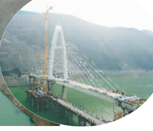
12月25日凌晨3点,随着最后一方混凝土入模,白郧汉江大桥主跨顺利合龙。据悉,白郧汉江大桥工程由中铁一局集团有限公司承建,位于白河县与湖北省郧西县交界处,横跨汉江而架,桥梁总长289米,主跨连续梁210米。此次主跨合龙段的浇筑,标志着白郧汉江大桥即将全线贯通,结束白水、郧西两县隔江相望的历史,进一步促进陕鄂两省路网连接,为陕鄂两省的经济腾飞而助力。 苟晓刚 刘显军 摄
