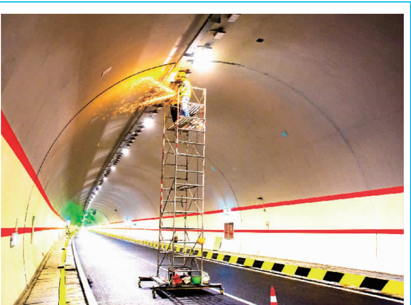
安岚高速即将通车,目前施工单位正在加班加点抓紧时间做最后的细化工作,按时完工确保顺利通车。图为12月17日,工程人员在安岚高速谢家坡隧道安装照明线路路防护板。
