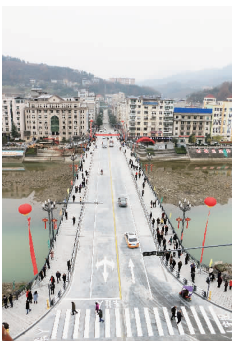
12月15日上午,岚皋县新建县城一桥提前两个月正式通车。一桥的正式通行大大缓解了县城车辆拥堵的压力,更加方便群众出行。随着岚皋县城骨架的拉大,旧桥的运载能力不足,被定位五类危桥。2020年3月16日,工程开工建设,该项目设计主桥宽度19.5米,引桥宽度17.5米,桥梁主体结构为连续箱梁,经过9个月的紧张施工,新县城一桥比预计时间提前2个月建成通车。
