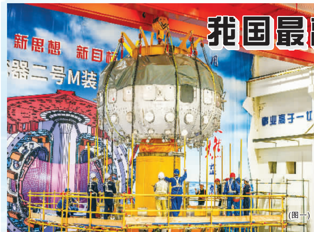
图一：中核集团核工业西南物理研究院的工作人员在安装调试中国环流器二号M装置时进行真空室吊装作业(2019年9月28日摄)。新华社发(中核集团核工业西南物理研究院提供)
