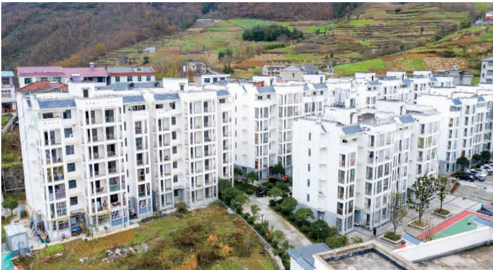
整洁的保障房小区
