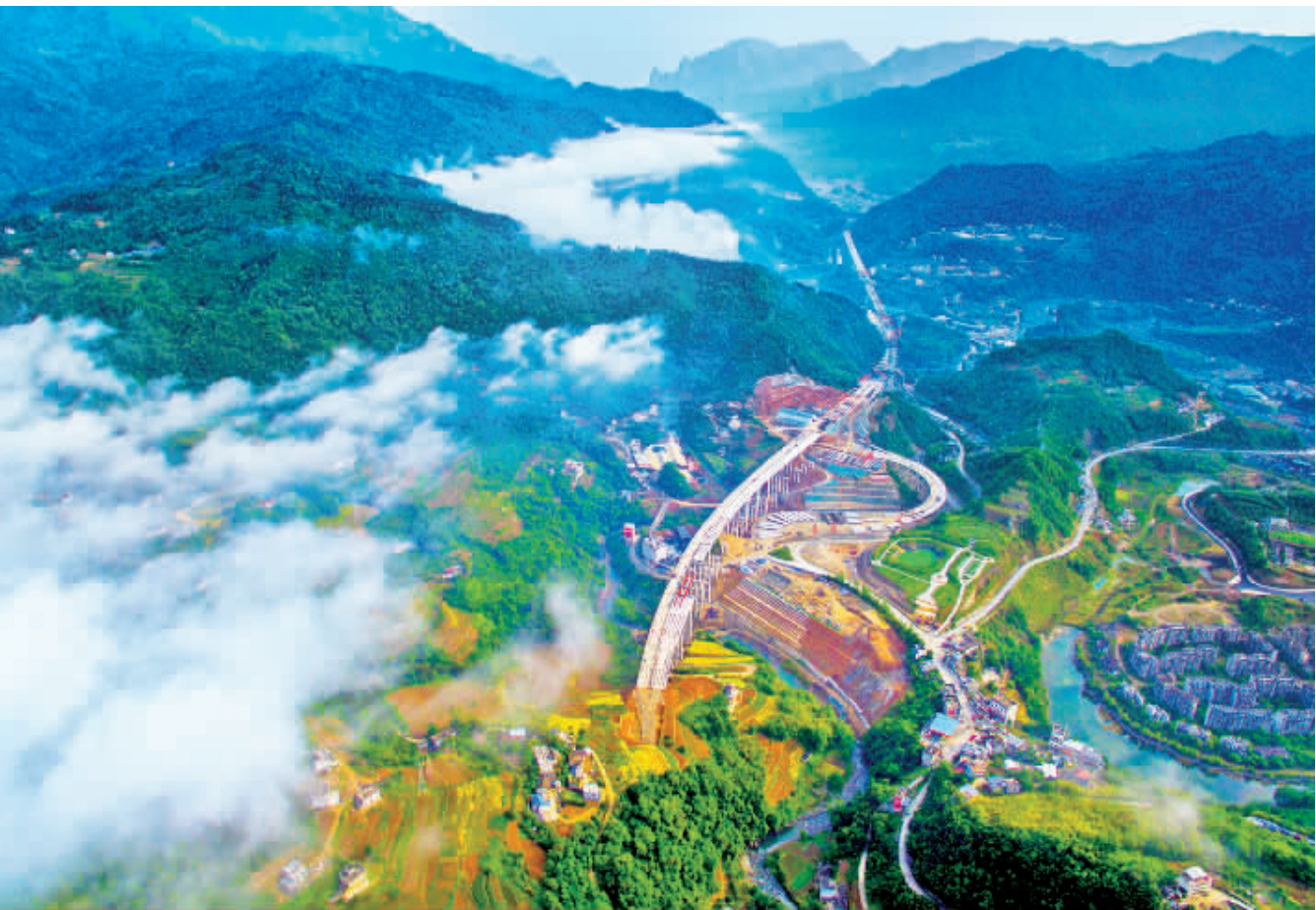
即将通车的安岚高速在崇山峻岭间延伸。安康至岚皋高速公路是国家高速公路网银川至百色线(G69)的重要组成部分，是我省“十三五”末实现县县通高速的重点“脱贫攻坚”项目。安康至岚皋段全长47.83公里，目前已经全部建设完毕，预计2020年12月底通车。 黄家勇 摄
