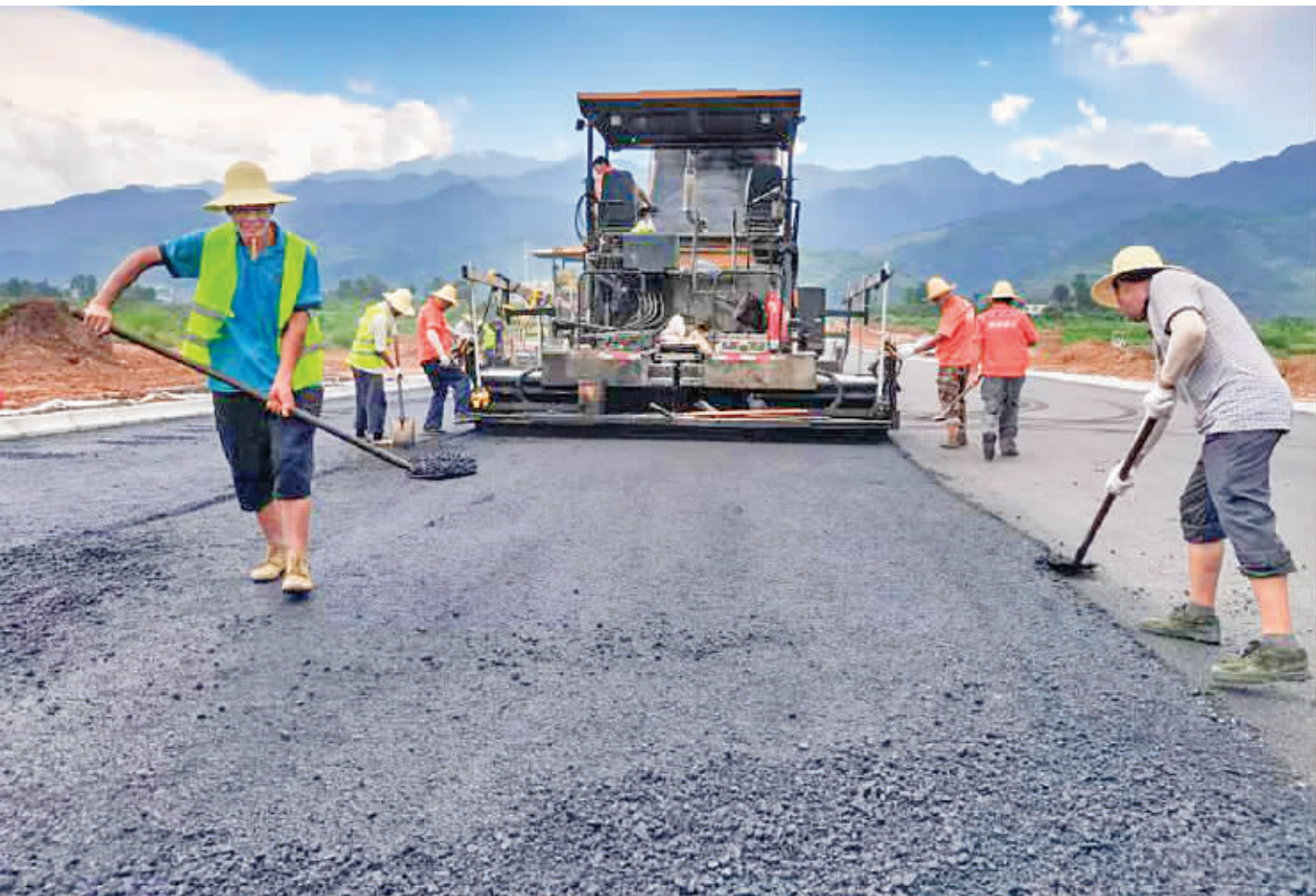
近日,石泉县经开区池河南北大道工程已进入路面铺设阶段,每天有20余台机械、近50名工人在场施工作业。据悉,该项目总投资2500万元,全长890米、宽26米。下一步,池河片区还将建成462米东西大道工程和5万平方米标准化厂房。
