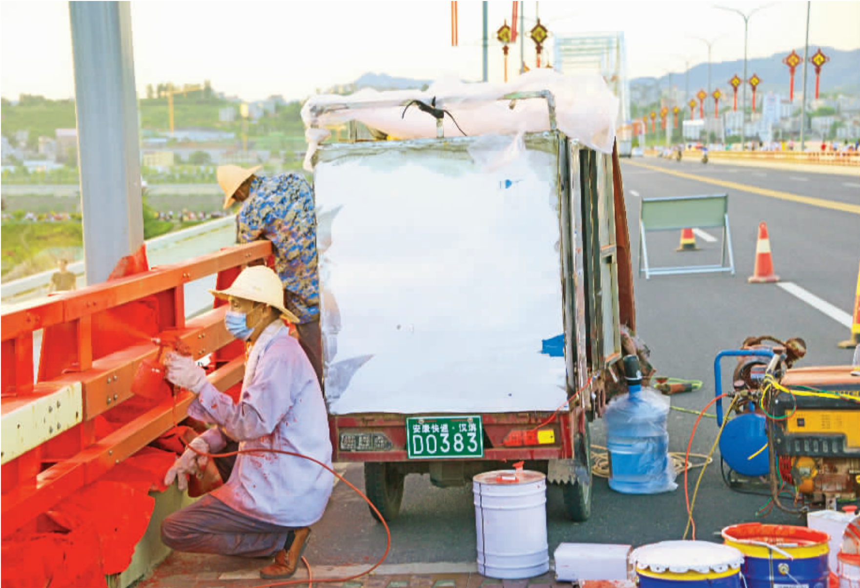
近日,工人对安康城区东坝大桥的铁栏杆进行喷漆,防止护栏生锈。
