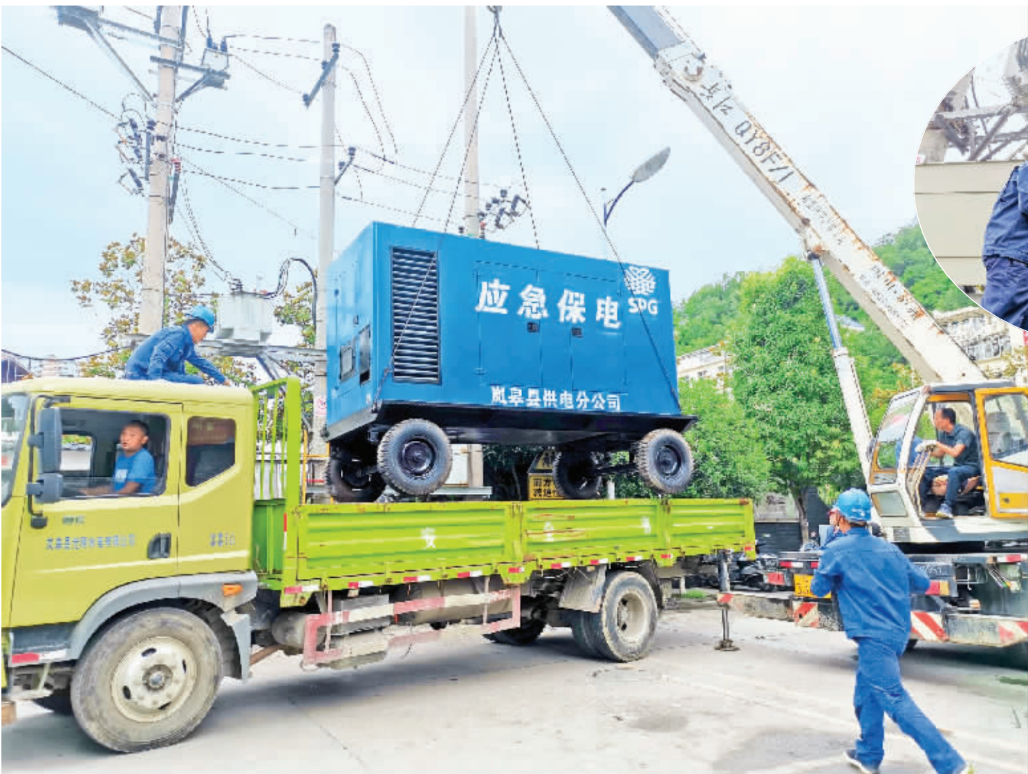
近日，为确保高考期间供电服务万无一失，岚皋县供电公司提前谋划部署高考保电各项工作，制定专项保障方案保供电。图为公司开展的今年高考保电应急演练。何军 摄
