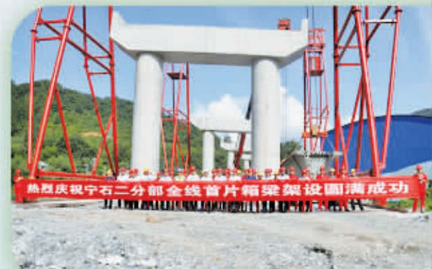
建设中的宁石高速公路。
