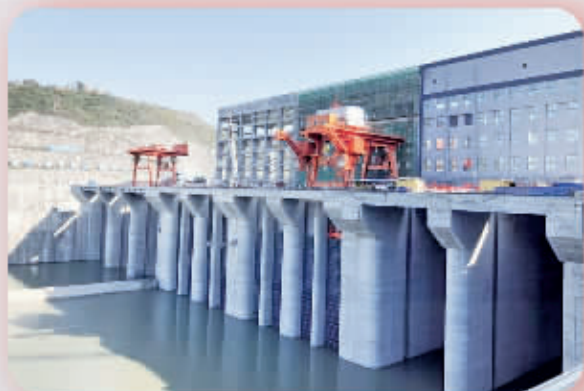
汉江白河水电站实现首台机组发电
