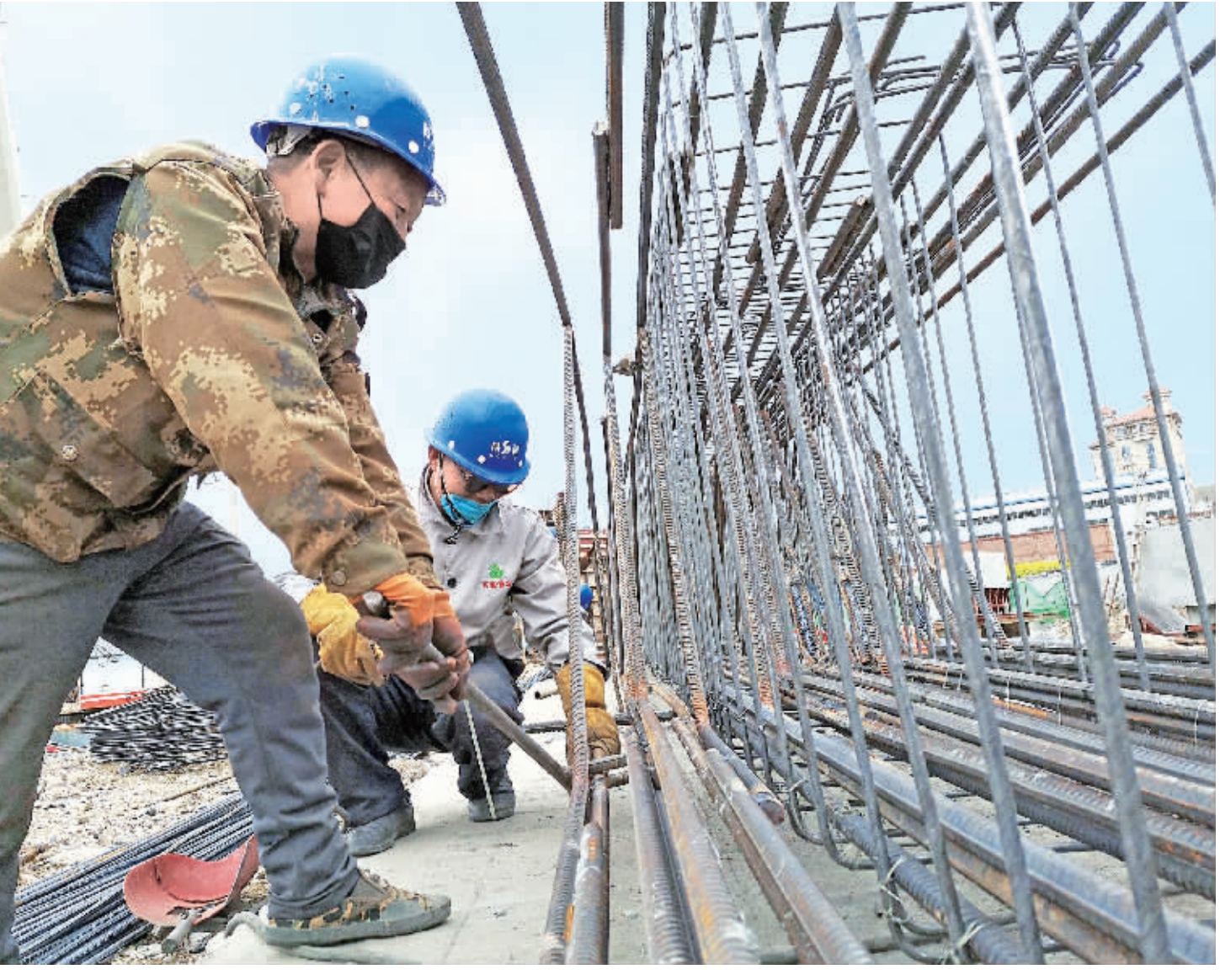
新安康大道冉河大桥是连接安康机场快速干道和冉河西路的的关键节点,在严格落实疫情防控责任措施的同时,紧盯目标任务抢抓施工工期。据了解,该段全长约2.1公里,主线桥梁主墩计划5月20日通行。图为新安康大道冉河大桥台盖梁钢筋绑扎施工。
