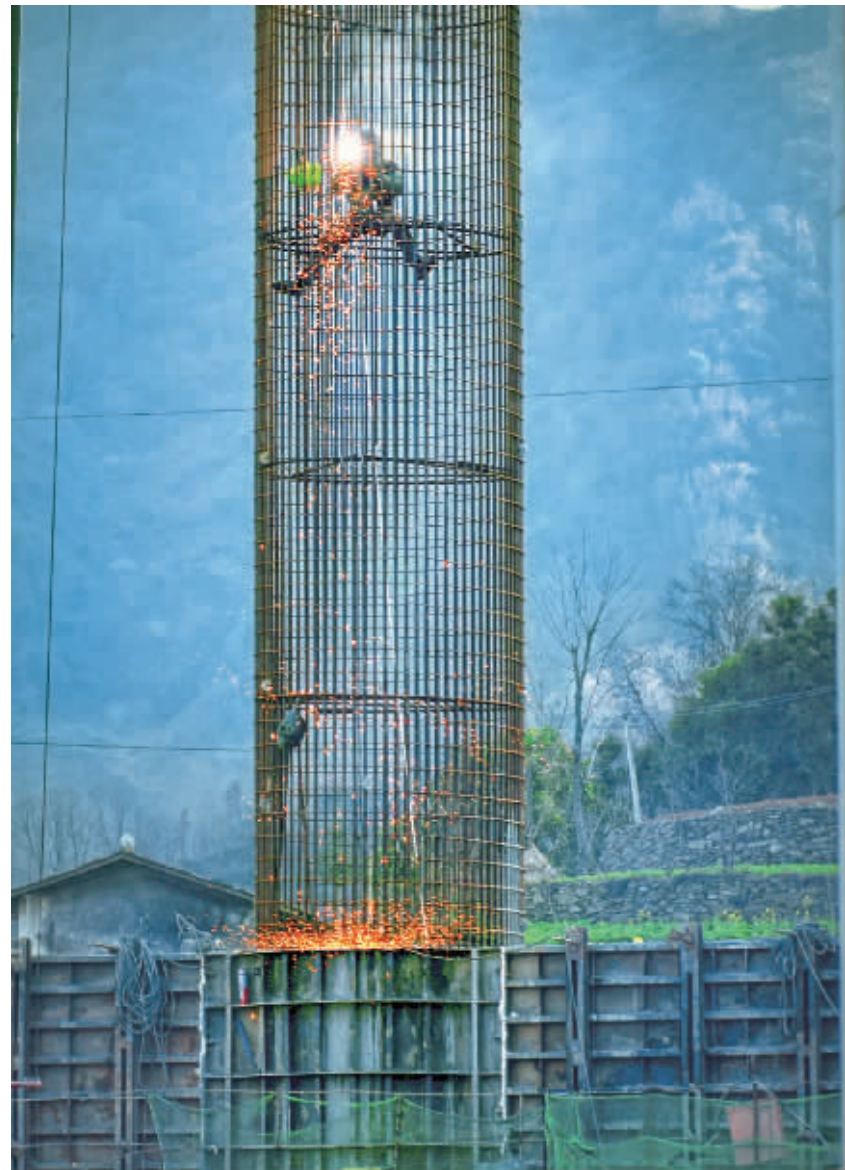
2月9日,岚皋县境内安康高速建设工程按照一手抓防控、一手抓复工的要求,有序组织各施工标段复工。图为电焊工人正在桥墩柱钢筋网上加紧施工。叶明星 摄
