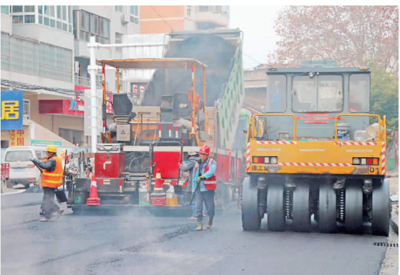
102省道旬阳县城区过境段(小河北加油站至党家坝加油站段)改建工程于1月14日开始放行。旬阳至小河二级公路改建工程城区过境段起于旬河大桥桥头,止于党家坝加油站十字,全长4千米。该项目于2019年9月11日开工建设,主要工程量包括路基开挖、油路面层铺市政管网铺设、混凝土路平石及路缘石等。项目历时三个多月,于当日主体完工,工程将极大缓解旬阳城区春运交通压力,方便群众出行。牛华 摄
