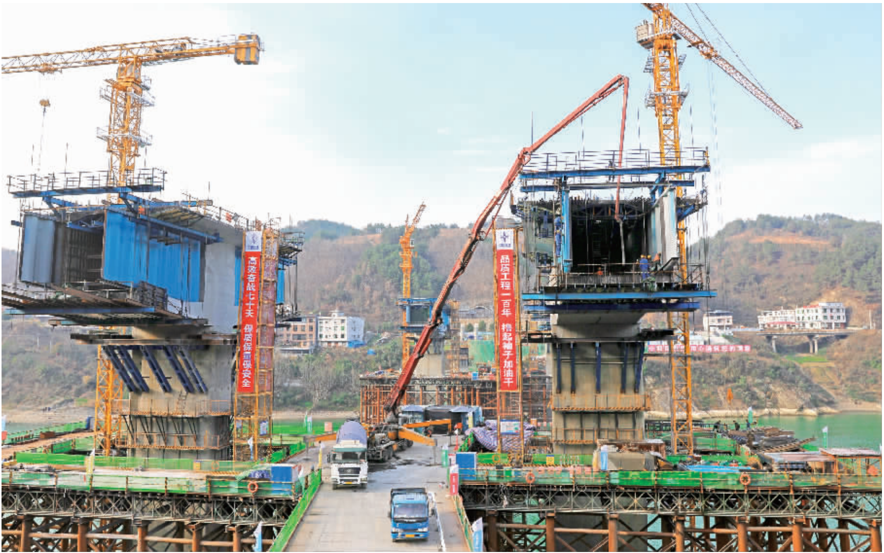
动工于2018年10月12日的安康至岚高速公路，是国家高速公路银川至百色线的重要组成部分。公路全长47.83公里，其间高山夹峙，河沟纵横，建设者们逢山开道，遇水搭桥，不误工期，预计2020年底有望通车投入运营。该工程对于建设美丽富裕新安康、助力陕南脱贫攻坚、实现省内“县县通”具有深远而重大的意义。图为时值数九寒天，位于汉滨区吉河口的安康高速公路大桥正在火热施工中。
