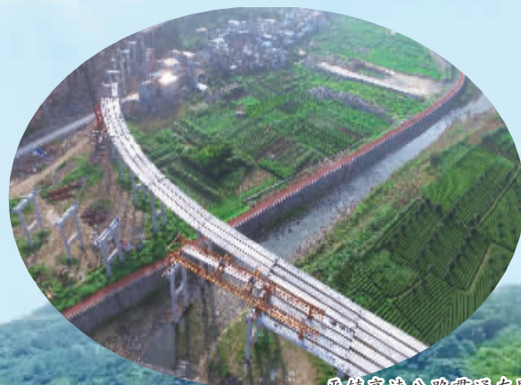
平镇高速公路贯通在即 本报记者摄
