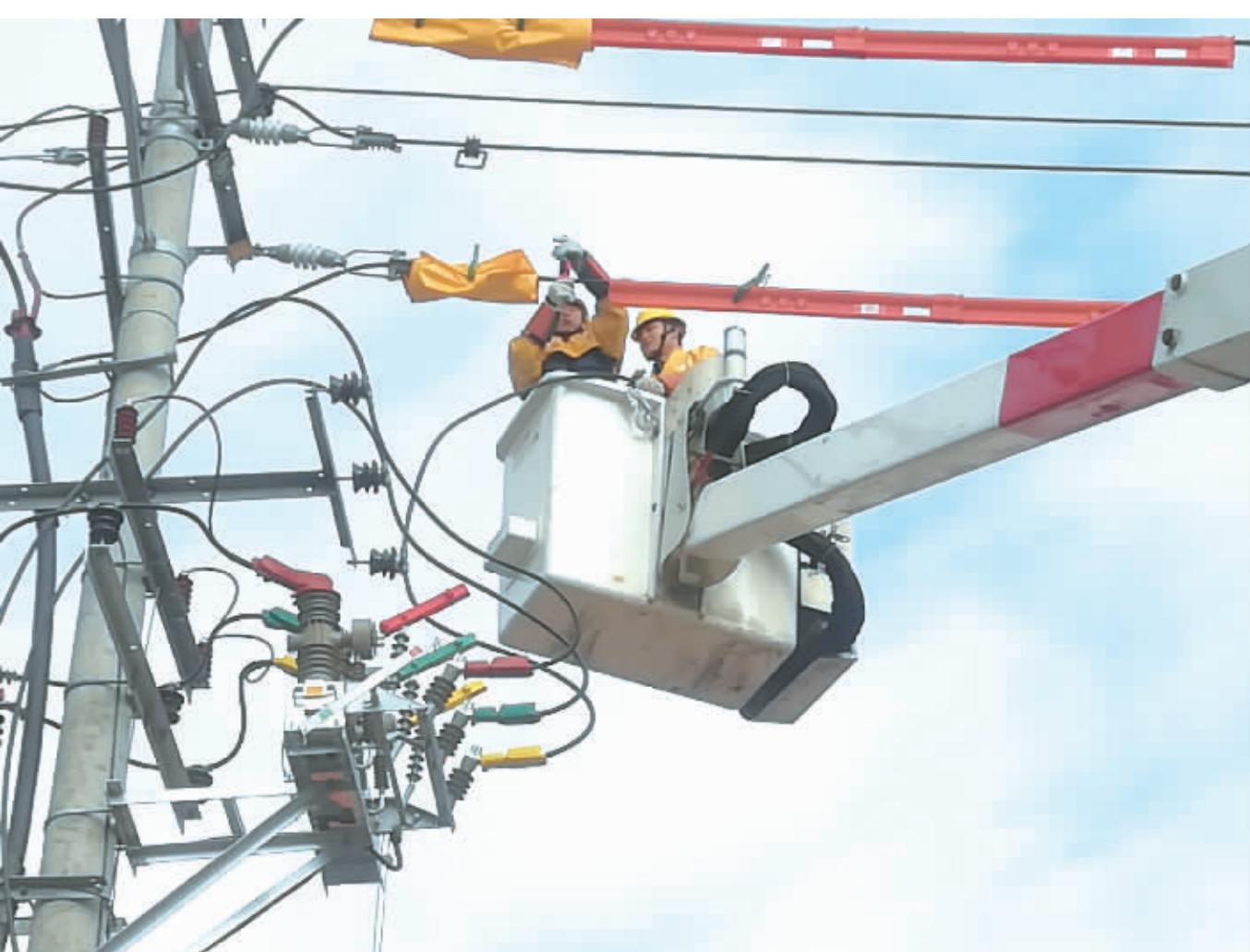
近日，安康供电公司汉阴带电作业班在岚皋县供电公司10千伏117罗家坪线3号杆为岚皋县兴皋医院进行带电接火作业（避免了辖区60台配变8200千伏安停电），在不停电的情况下最大限度为客户解决用电难题。为确保迎峰度冬期间连续可靠供电，岚皋县供电公司坚持“能带不停”的原则，以持续提高配网供电可靠性为目标，全面开展配网带电作业工作，为全县配网安全运行提供了强有力的支持和保障。
