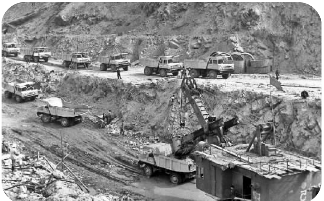
改革开放初期，安康重点项目建设工地出现了进口货运车。 吴定国 摄于1979年
