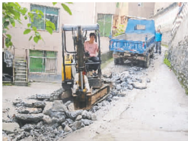
近日,在岚皋县城凉水井巷,传来破碎机“铛铛”的作业声,巷内路段已经搭起防护围挡,在住建部门的推动下,小巷正式开工建设。据了解,小巷投入近10万元,约500平方米路面进行硬化及排水等配套设施进行改造,预计8月20日左右完工,以实事工程温暖百姓民心。小巷将迎来变身,届时,达到“路平、水畅、灯亮”的标准提升当地经济发展。图为凉水井巷改造施工现场。廖霖 摄
